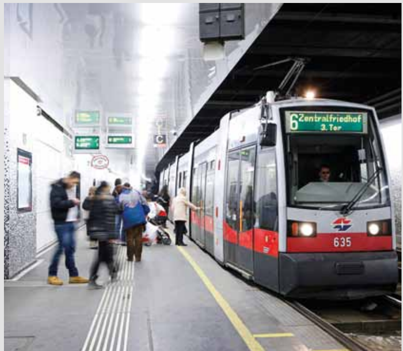
Neu sanierte Station Matzleinsdorfer Platz, Linie 6
